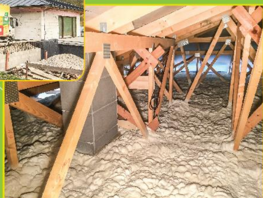
Súl'ov: väzníkový krov, aplikácia z vrchu
