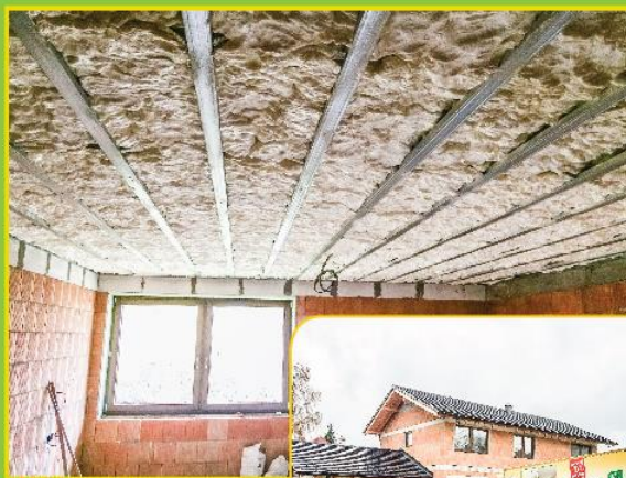
Višňové: aplikácia stropu
